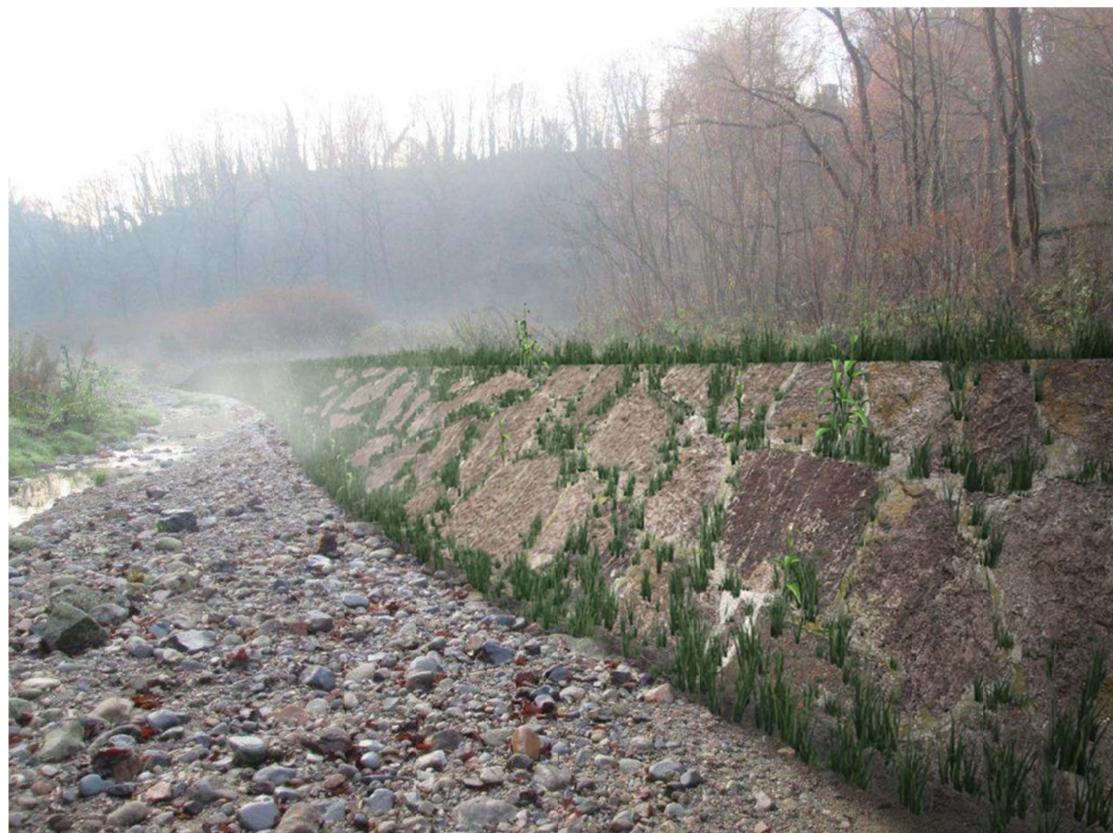
CONDIZIONE DI PROGETTO - SIMULAZIONE SCOGLIERA RINVERDITA
